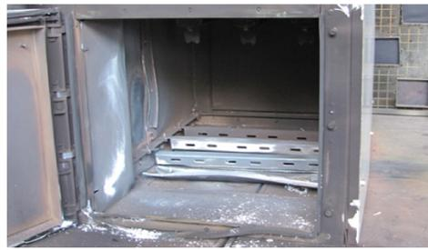
Durch Lichtbogen zerstörte Schaltanlage
